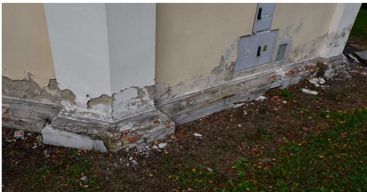
Il. 4: Zawilgocony i zerodowany cokół kaplicy od strony wschodniej, IX 2023
