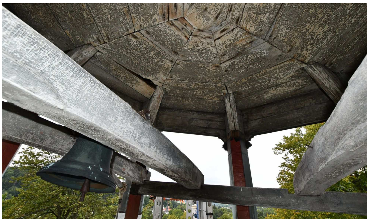
Il. 8: Wnętrze przezrocza wraz z konstrukcją wsporczą i dzwonem, IX 2023.
