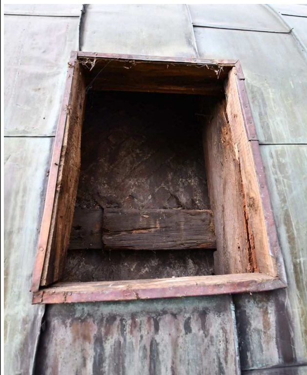
Il. 11: Otwór rewizyjny w południowej połaci kopulastej czaszy więźby, IX 2023.
