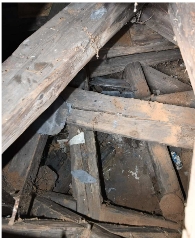
Il. 10: Wnętrze więźby dachowej, widok na murowaną czaszę kopułym IX 2023.
