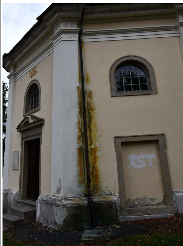
Il. 3: Ściana południowo zachodnia, z zaciekami wzdłuż rur spustowych, IX 2023
