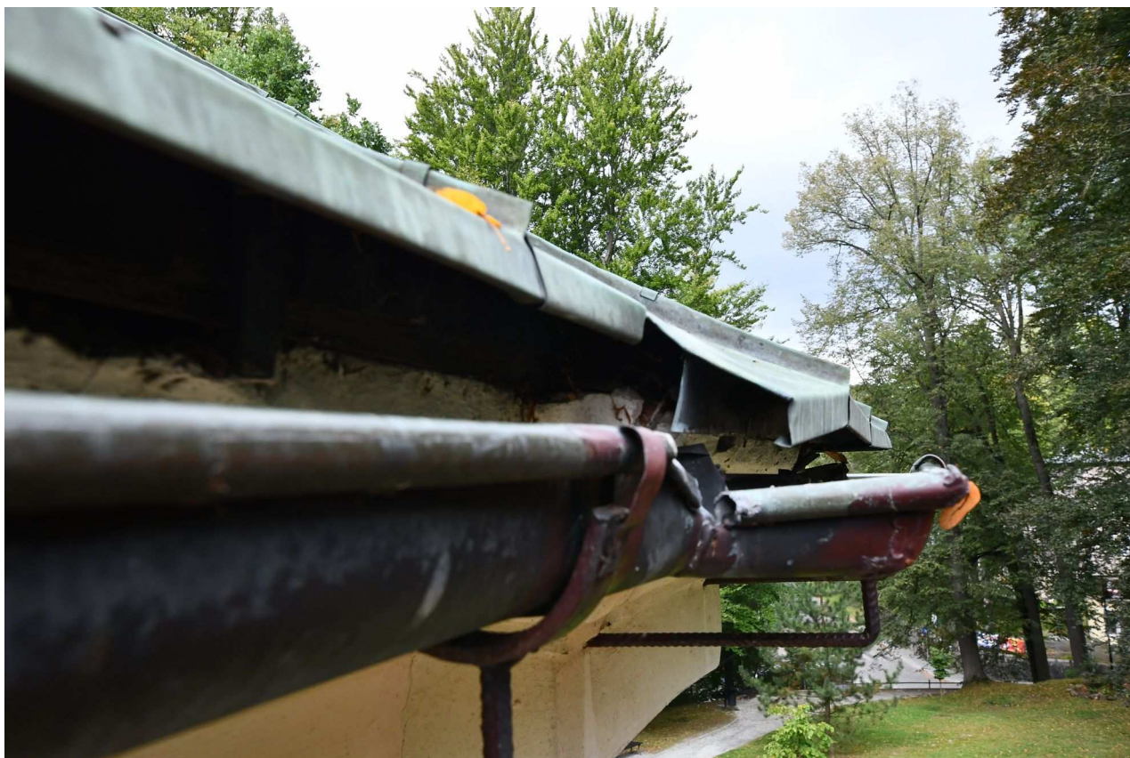
Il. 5: Uszkodzone i rozszczelnione rynny. IX 2023
