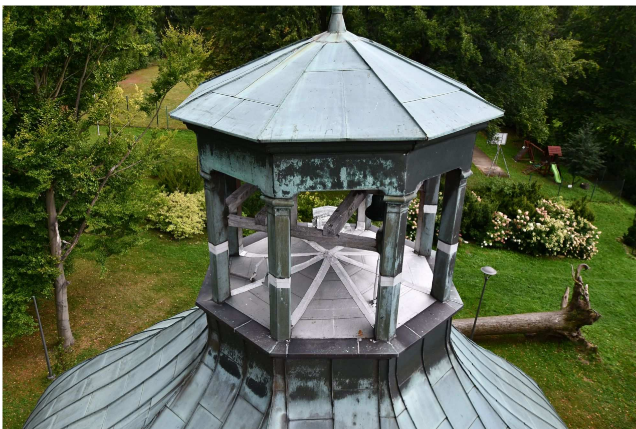
Il. 6: Latarnia (przezrocze), kopulastej czaszy. Widoczne nieszczelności uzupełniane taśmą izolacyjną. IX 2023.
